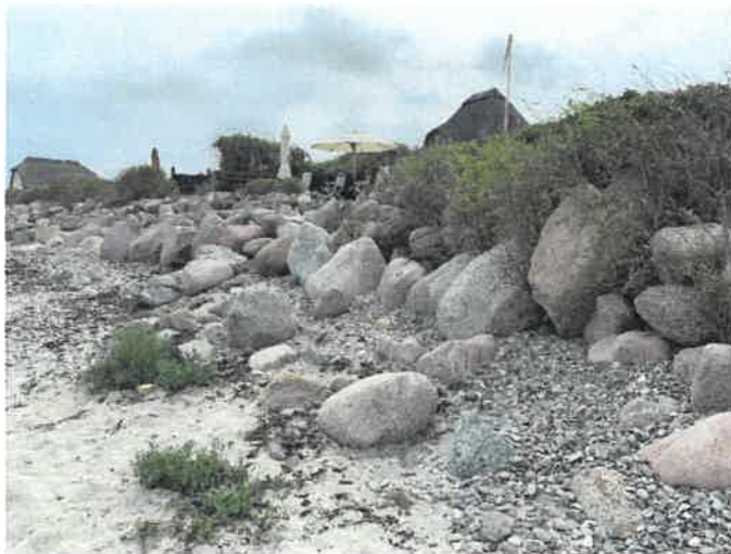
Figur 2.8: Nuværende skråningsbeskyttelse i den sydvestlige ende af delstrækning B.
