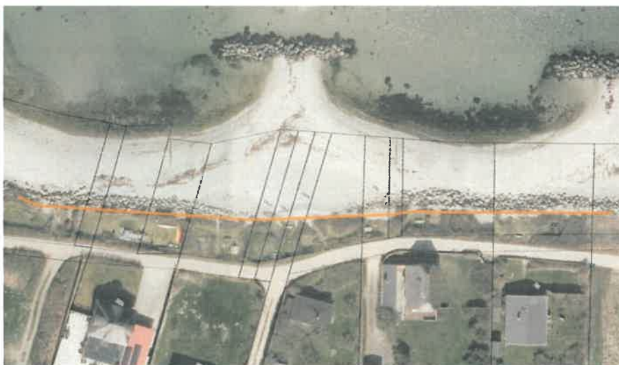
Figur 2.7: Delstrækning B, her landværts markeret med orange linje, er en skråningsbeskyttelse med uensartet kotehøjder og dækstensstørrelse. Som ved delstrækning A er bølgebrydere medvirkende til god samlet kystbeskyttelsesniveau med tombolodannelse.
